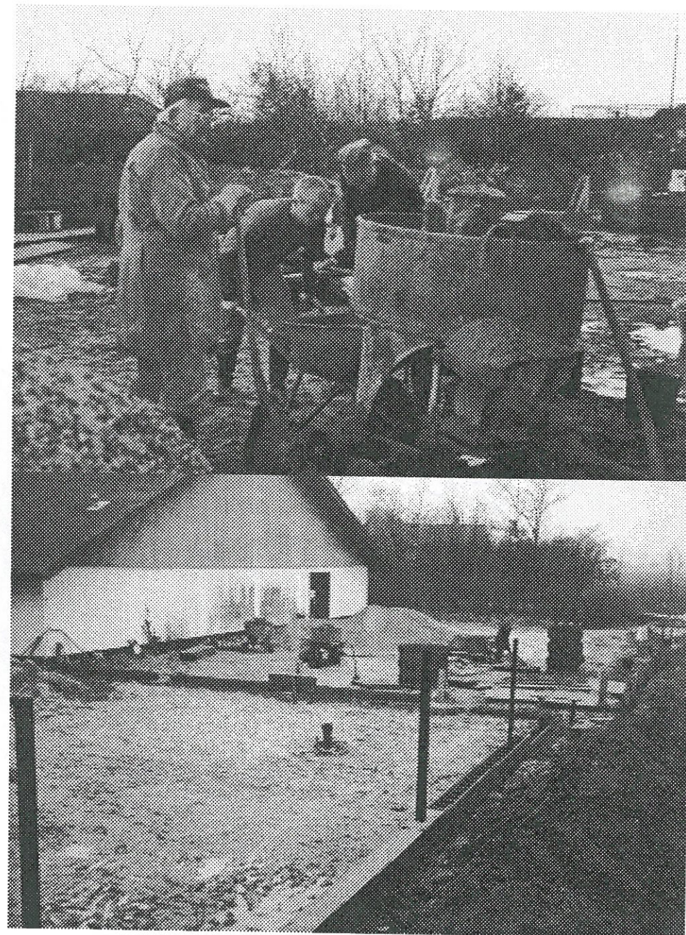
Det går stille og roligt fremad med byggeriet af det nye kultur- og idrætscenter i Hunderup. Her blandes der cement i lange baner til soklen.
