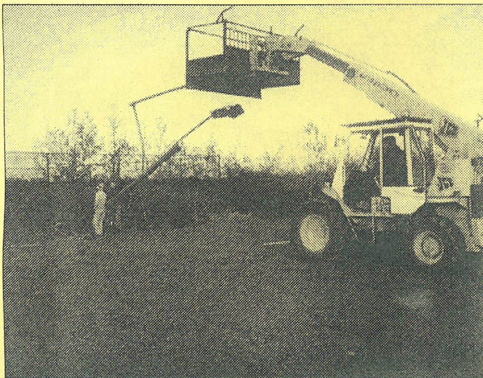
Frivillig rejsning af lysmast ved tennisbanen oktober 1995.
