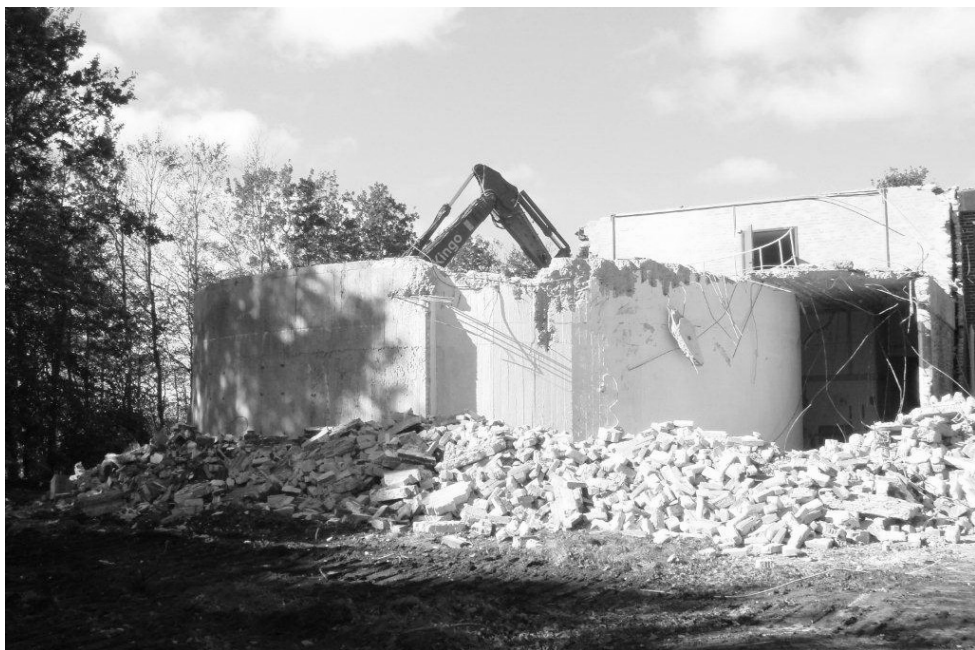
Nedrivning af vandværket.
