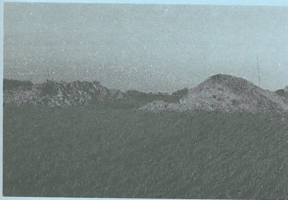
UDGRAVNINGSSARBEJDET I HUNDERUP MARK
