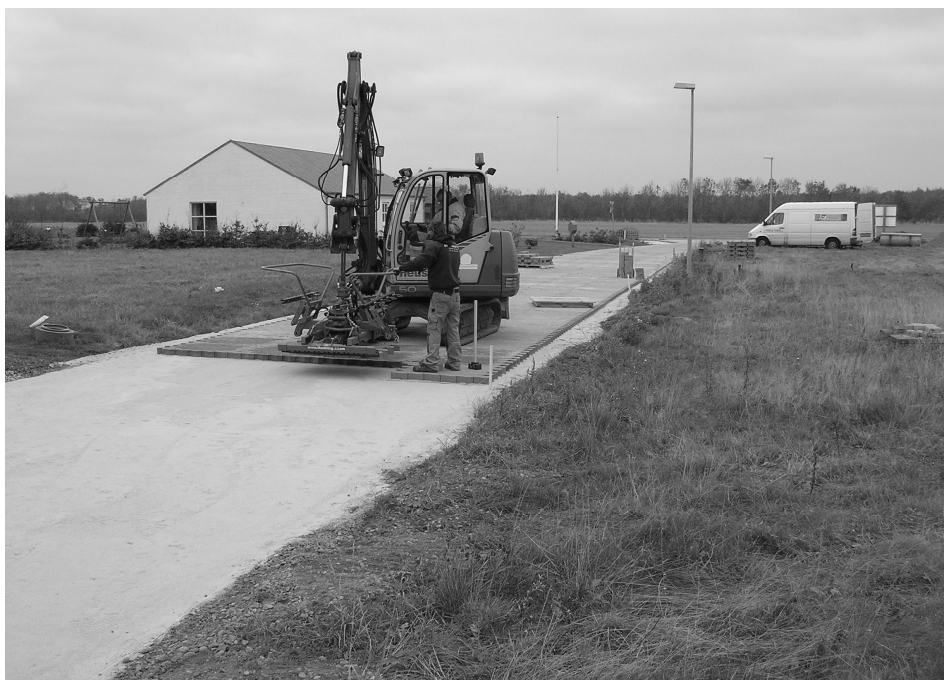
Esbjerg Kommune i gang med at etablere belægning på Møllevænget.
