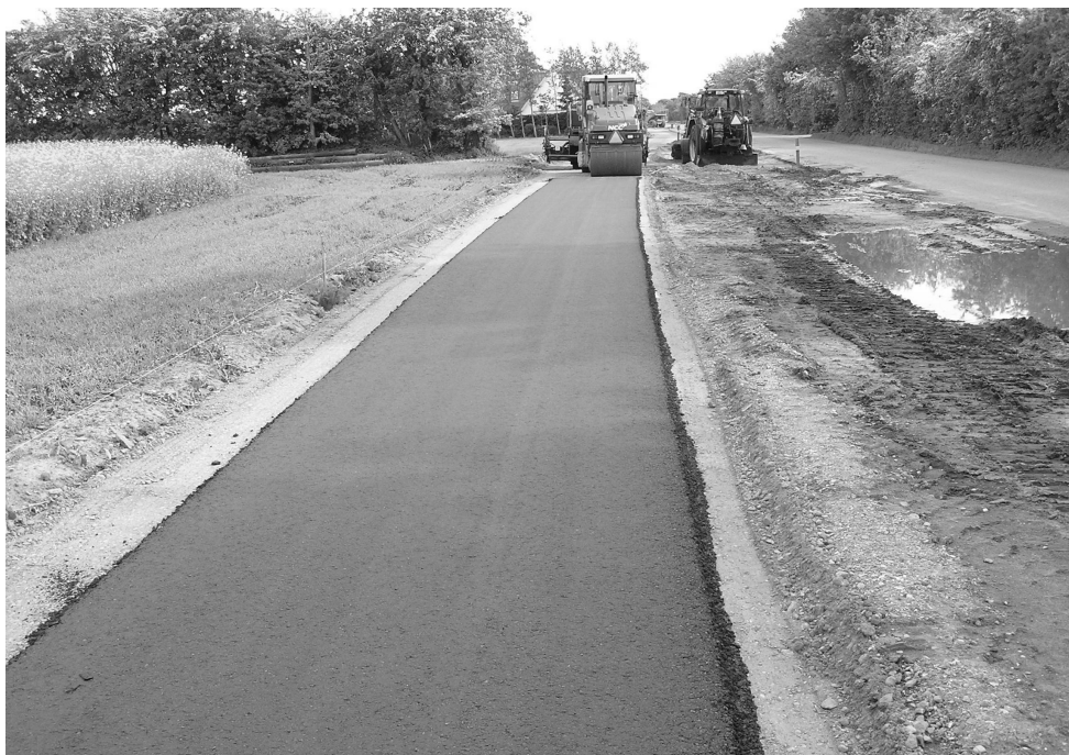
Så kom der asfalt på den nye cykelsti
